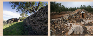
1. Marge amb pedres regulars, allargades i en disposició horitzontal. Presenta un coronament en rastell inclinat (Masdenverge).
